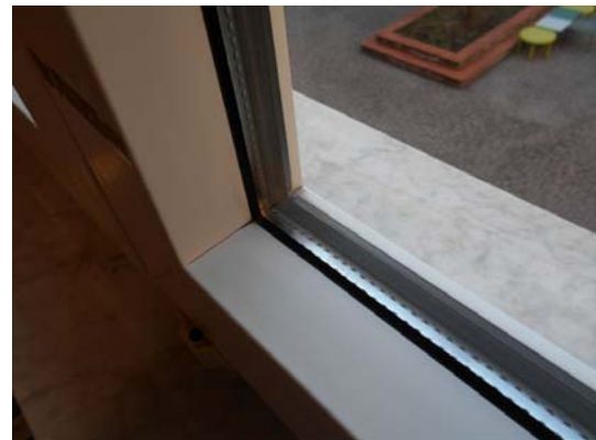
Figura 2.3 - Particolare dei serramenti – dettaglio angolo vetro
